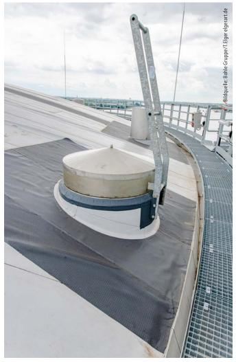
Um riesige, gewölbte Tank- und Speicherdächer dämmen zu können, hat das Unternehmen Bohle Isoliertechnik GmbH vor Jahren ein innovatives Dämmsystem entwickelt.
