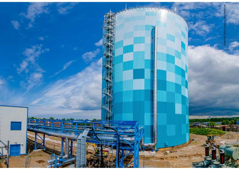
Die Stadtwerke Rostock haben im Hinblick auf die Energiewende nachhaltig investiert und einen 55 m hohen Wärmespeicher errichtet. Von besonderer Bedeutung war dabei das Dämmkonzept der Bohle Isoliertechnik GmbH.
